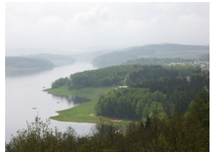
Die Talsperre Pöhl
