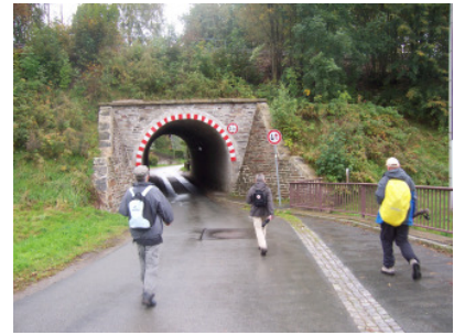
Bahnstrecke Bad Brambach - Elster
