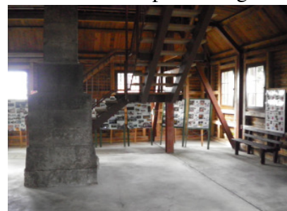
Vermessungssäule mit Aufgang
