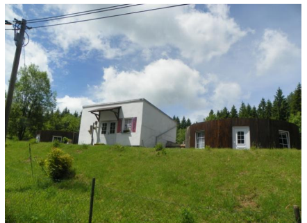
Eine neue Gebäudetechnik
